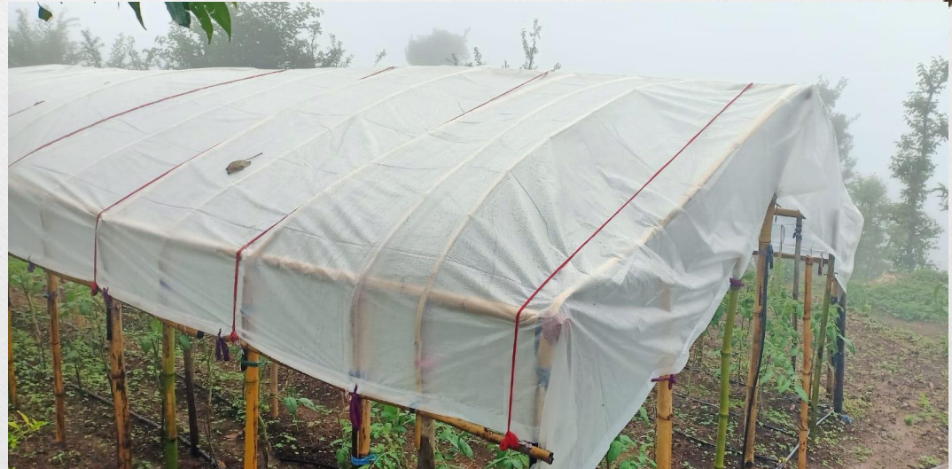
वडा नं ३ मा पालिकाद्वारा प्लास्टिक घर निर्माण
