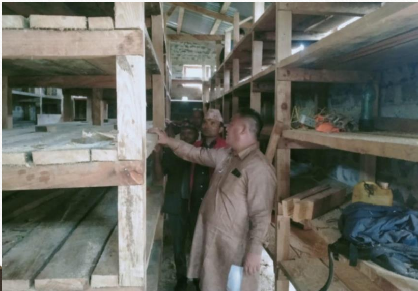
रस्टिक स्टोरको निर्माण प्रक्रियामा अनुगमन
